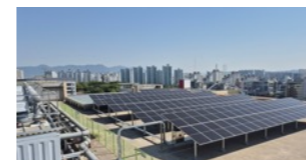
[롯데쇼핑] 태양광 패널 설치
